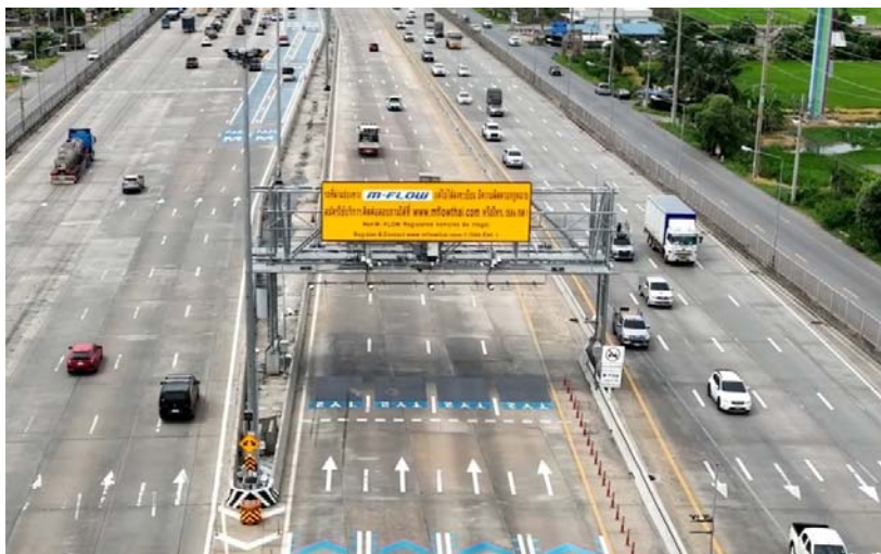
ภาพที่ 8 ป้ายแจ้งเตือนการจราจรช่อง M-Flow ที่มา : กองทางหลวงพิเศษระหว่างเมือง กรมทางหลวง
