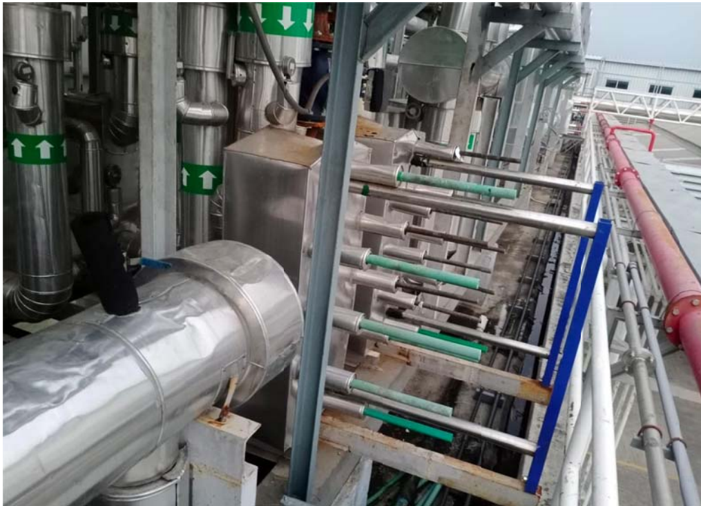
ภาพที่ 7 ฮีทเพทแลกเปลี่ยนความร้อน
