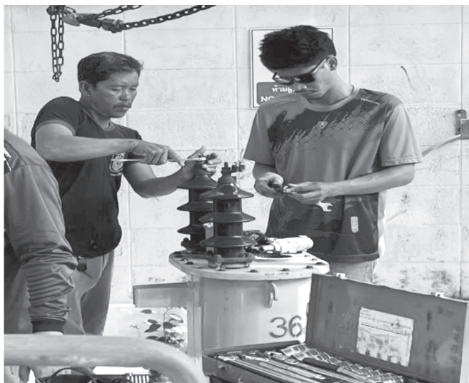
ภาพที่ 2 วิธีการถอดประกอบหม้อแปลงไฟฟ้าโดยใช้ประแจแบบปกติ
