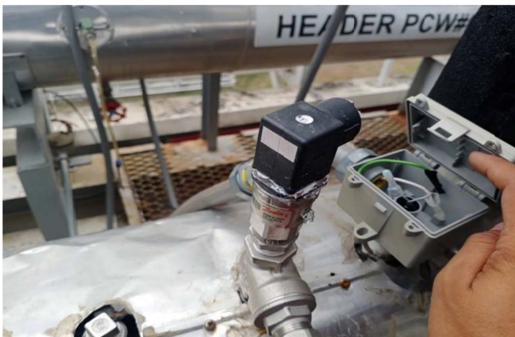
ภาพที่ 10 เซ็นเซอร์อุณหภูมิ
